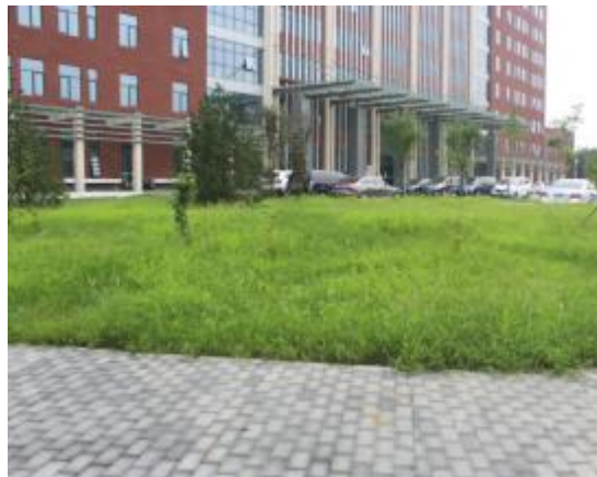
综合楼北侧绿化、及人行步道透水砖铺装
