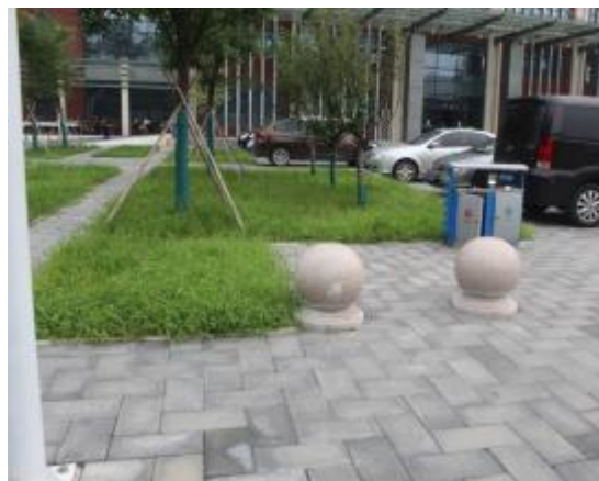
综合楼北侧人行步道透水砖铺设
