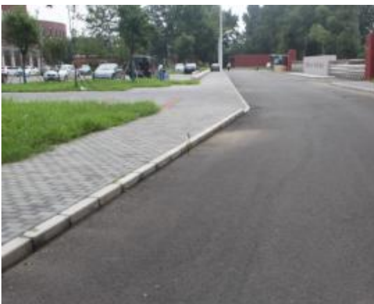
综合楼北侧绿化道路透水混凝土铺设
