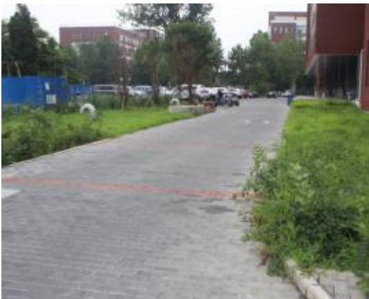
综合楼前绿化、及人行步道透水砖铺装
