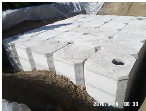
雨水收集池回填 (2016年6月)
