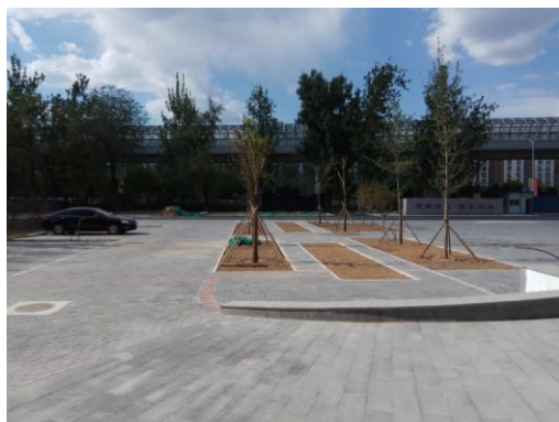
广场透水铺装 (2017年4月)
