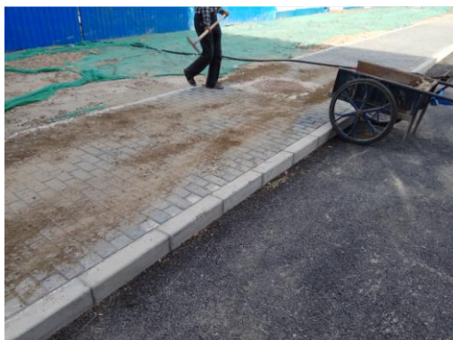
人行道透水铺装 (2017年2月)
