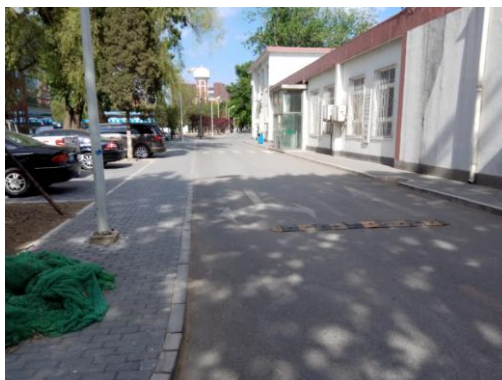
人行道透水铺装 (2017年2月)
