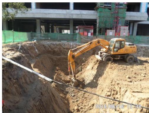
雨水收集池开槽 (2016年6月)
