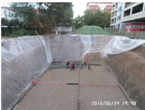
雨水收集池施工 (2016年6月)
