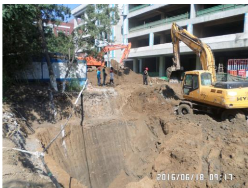
雨水收集池开槽 (2016年6月)
