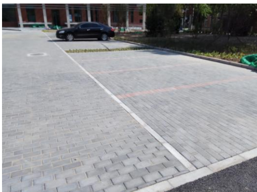
停车位透水砖铺装 (2017.4)
