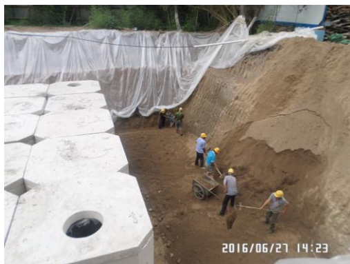
雨水收集池回填 (2016年6月)
