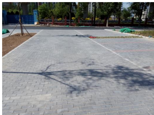
停车位透水砖铺装 (2017.4)
