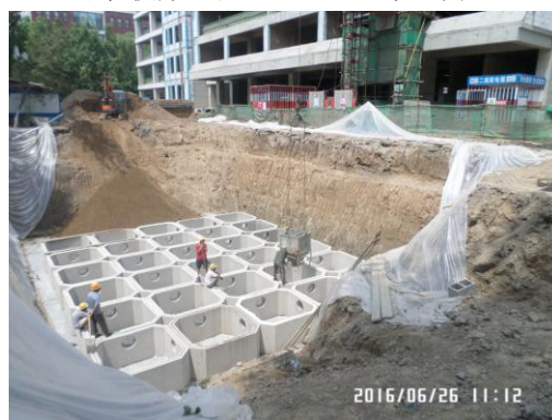
雨水收集池施工 (2016年6月)
