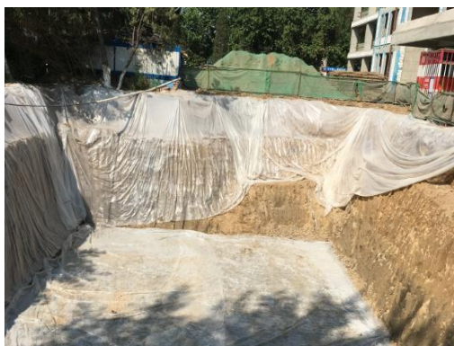
雨水收集池施工 (2016年6月)
