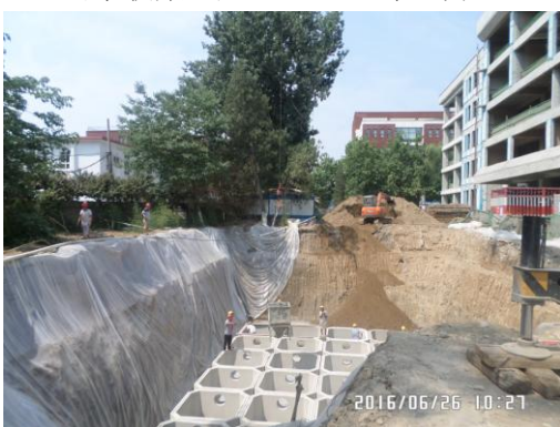
雨水收集池施工 (2016年6月)
